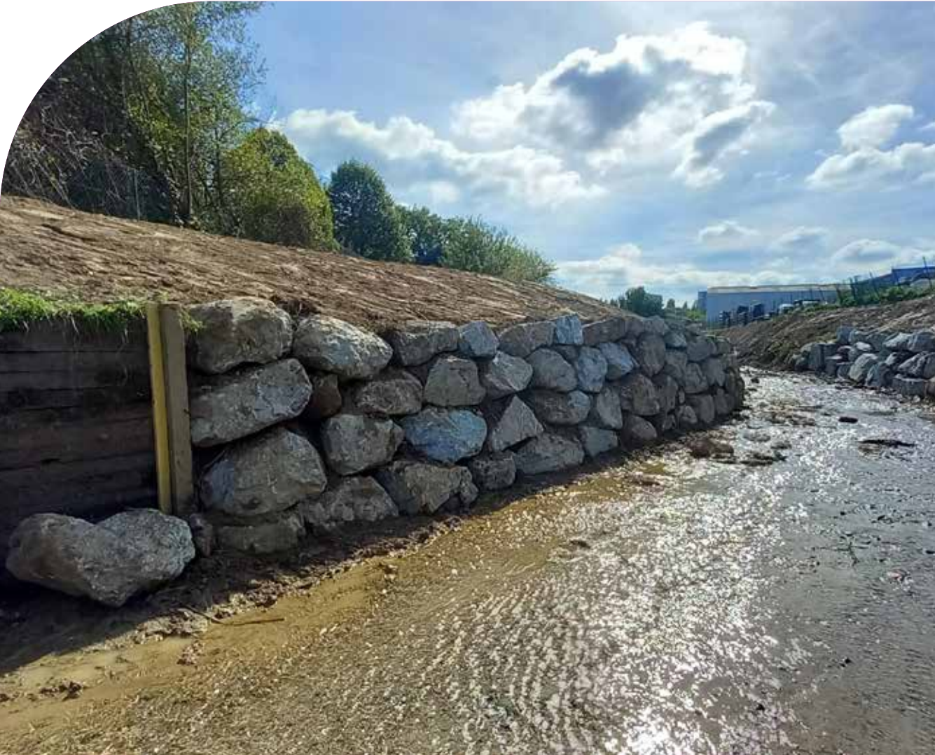
Enrochement des berges du ruisseau des Chers
