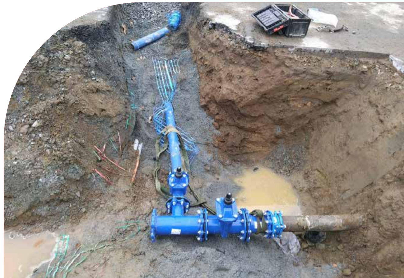
Travaux de renouvellement de réseau d'eau potable – Rue de la petite Neuville à Montaigut-le-Blanc
