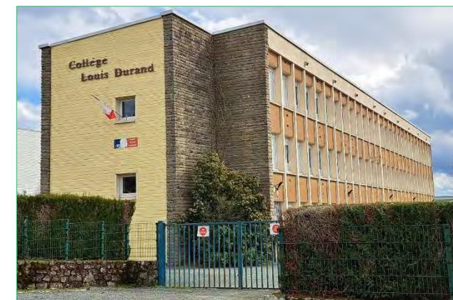
Collège Louis Durand à Saint-Vaury - ©La Montagne
