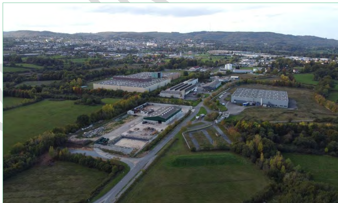
Parc Industriel de Guéret - ©DDT Creuse
