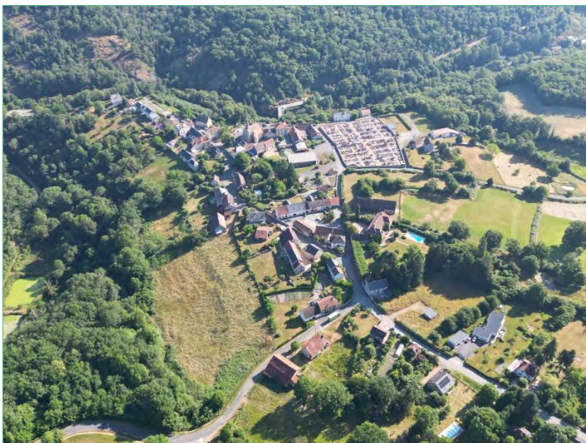
Vue aérienne du bourg d'Anzême - ©Campus Développement
