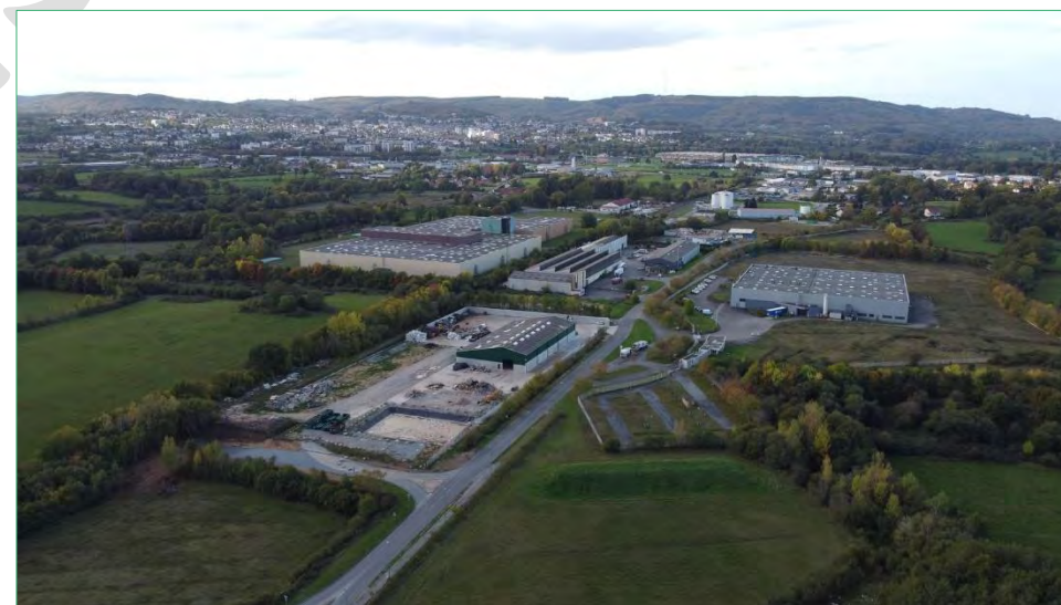
Parc Industriel de Guéret - ©DDT Creuse
