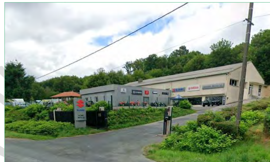
Site d'activités économiques à Peronceau à Guéret - ©Google Street View
