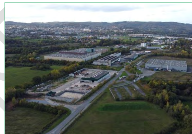
Parc Industriel de Guéret - ©DDT Creuse
