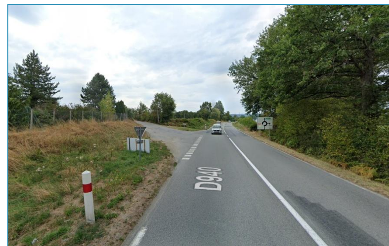
Vue sur le carrefour desservant actuellement les villages Cher de Bas et Cher de Haut depuis la RD940 ©Google Street View
