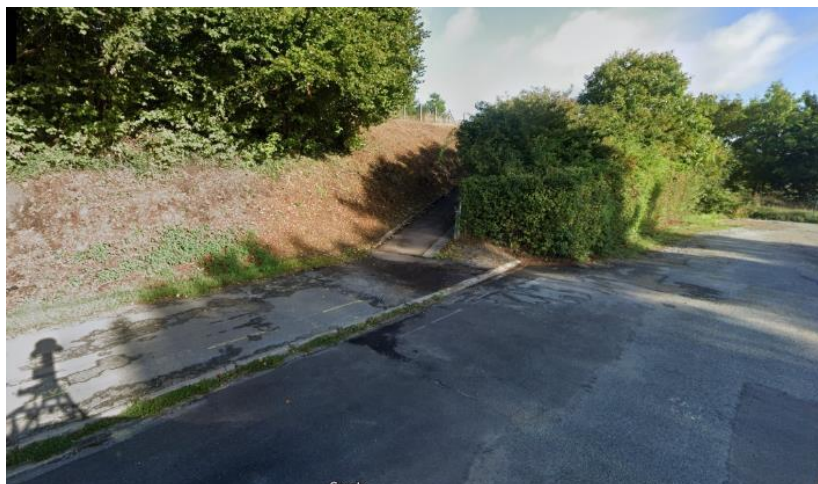
FIGURE 49 PASSERELLE AU-DESSUS DE LA RN145
