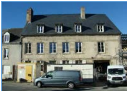
Future MSP en travaux
