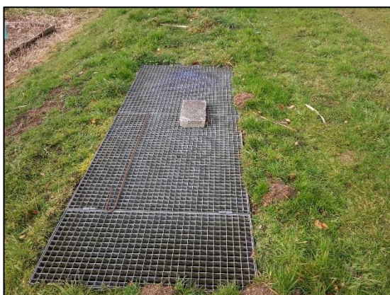
Photo 6 : Vue de la chasse
