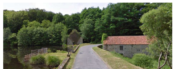
Déversoir installé sur l'étang communal
