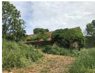
Bâtiment annexe totalement recouvert par la végétation
