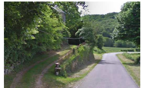
Chemin d’accès au terrain, soutenu par un mur de pierres sèches recouvert par la végétation
