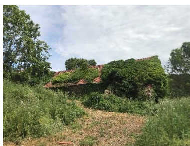
Bâtiment annexe totalement recouvert par la végétation
