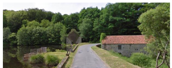
Déversoir installé sur l’étang communal
