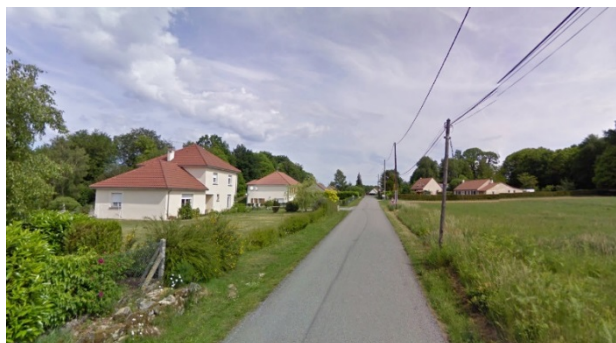
Vue sur une partie des constructions des années 1990-2000
