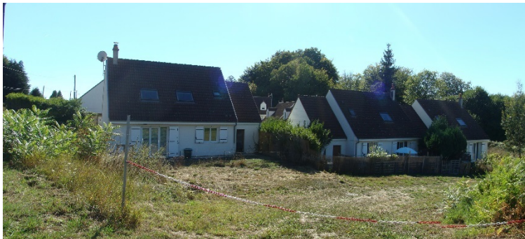
Vue sur les logements sociaux France Loire
